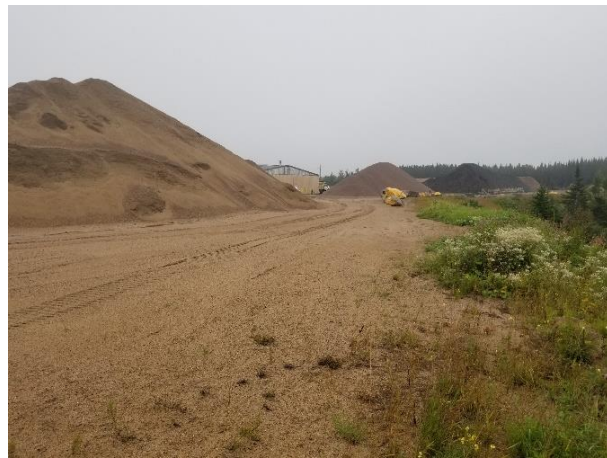
Figure 3: Chemins d'accès à proximité de la crête du talus
