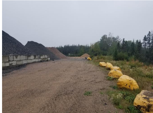
Figure 2: Entreposage des matériaux proche de la crête du talus
