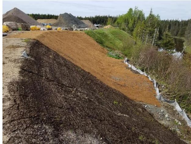
Figure 1: Mise en place du matelas anti-érosion
